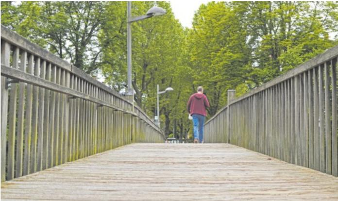
*Pilzbefall, Verwitterung und Feuchtigkeitsschäden haben der Altrheinbrücke in Verlängerung der Großherzog-Friedrich-Straße zugesetzt. Der 1987 erbaute Übergang muss deshalb durch einen Neubau ausgetauscht werden. Foto: Stadt Kehl/Mark Gregotsch*
