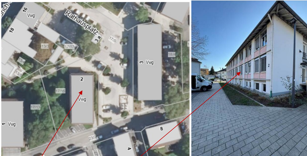
Abb. 1: Baufensterbereich, abzureißendes Bestandsgebäude
